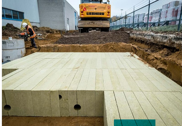
Steinwolle hat eine große Versickerungsfläche.
