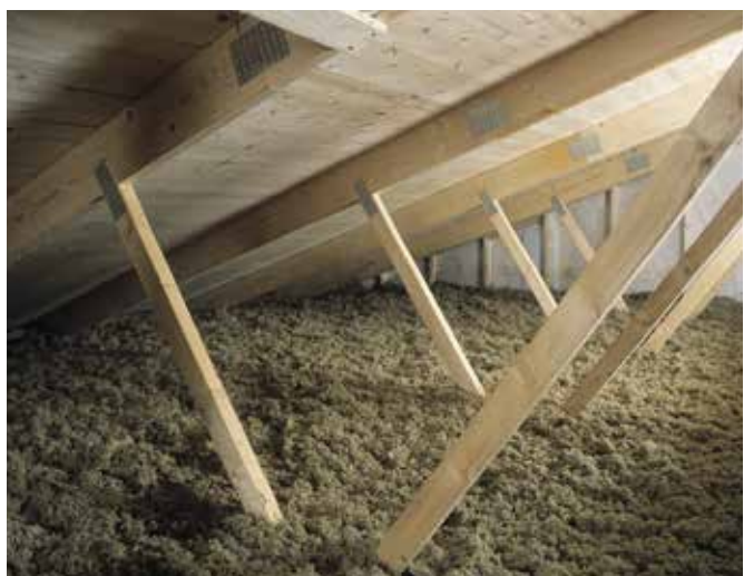
6. Ferdig isolert loft.
