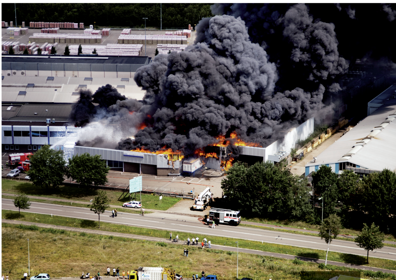
Uitslaande brand met brandbare isolatie (begonnen tijdens werkzaamheden op het dak) bij KOMA Koeltechniek
