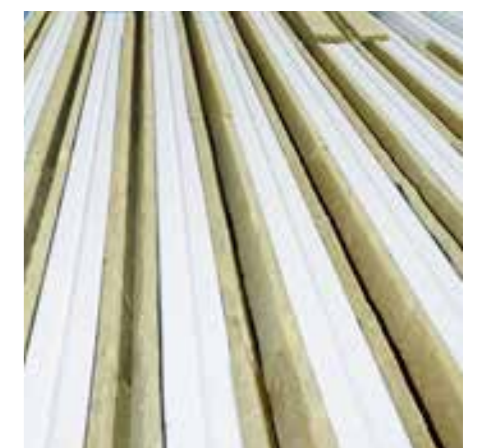
Einlegen von Akustik-Profilfüllern in Trapezprofile
