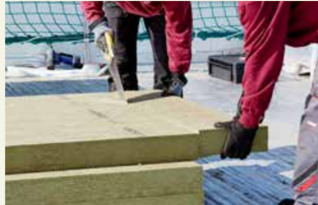
Die Dämmplatten lassen sich leicht zuschneiden.
