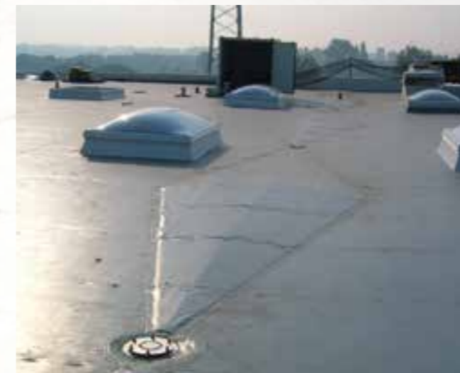
Punktentwässerung entlang der Kehllinien
