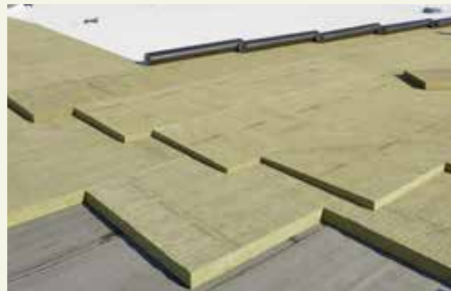
Die Verlegung der Dämmplatten erfolgt im Verband.
