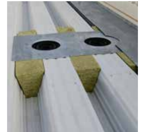
Brandschutz bei Stahlblechdächern
