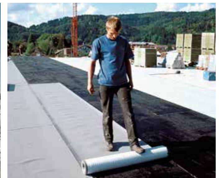
Dachaufbau verklebt
