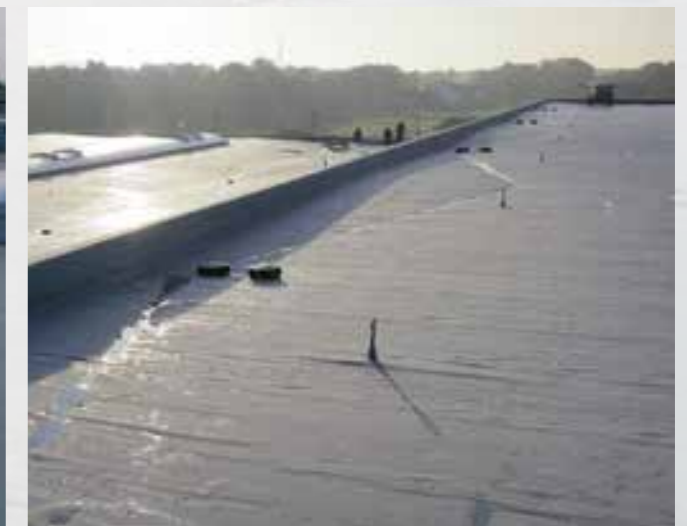
Punktentwässerung entlang der Attika
