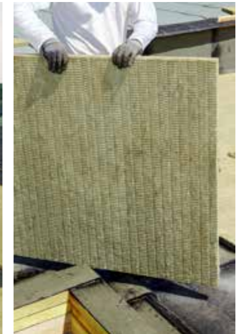
Verlegung der RP-TF auf ausgebessertem altem Dachaufbau
