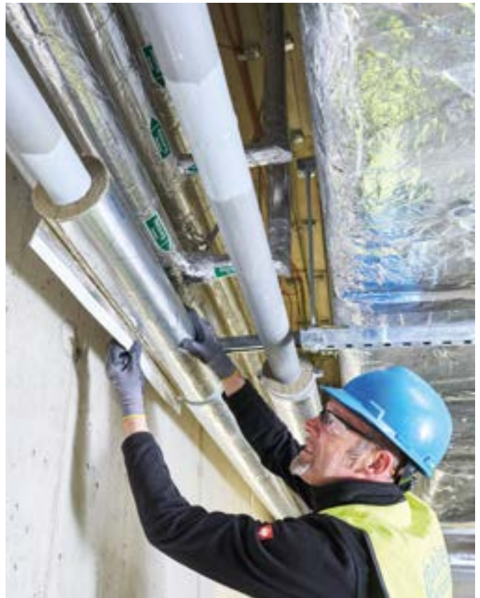
Montage der ROCKWOOL 800 an Heizungs- und Trinkwasserleitungen
