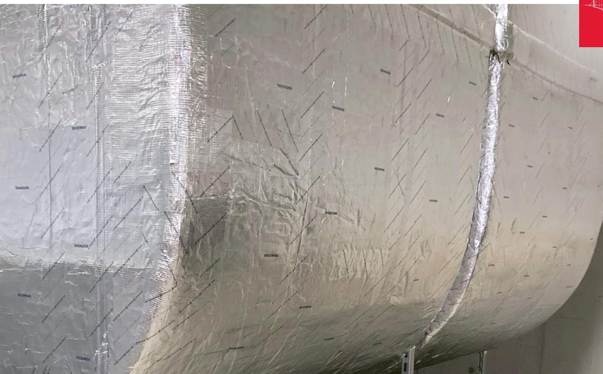
Teclit LM Cold EF ist eine ebenso robuste wie flexible Steinwolle-Lamellenmatte mit vertikaler Faserausrichtung und einer besonders hochfesten glasfaserverstärkten Aluminiumfolie. Sie ist auf der Steinwolle-Seite mit einer selbstklebenden Beschichtung ausgestattet und kann somit schnell und einfach an Lüftungskanälen befestigt werden.
