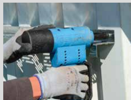
2 Fixation des Z THERMIQUES® sur ossatures de renfort fixées dans la structure
