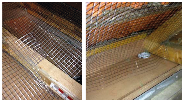
Figure 6 : Découpe et pliage du grillage en correspondance des entrants (gauche) et maintien de l'aération (droite)
