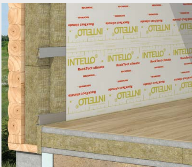
Ułożenie paroizolacji ROCKTECT Intello Climate Plus.
