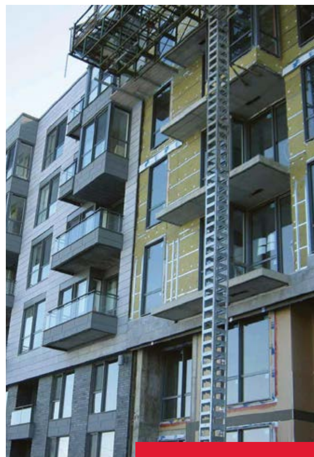
Projet Soleno, Montréal (PQ) ROCKWOOL Cavityrock MD
