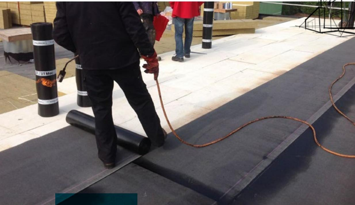
Multifix<sup>MC</sup> de ROCKWOOL est le premier produit isolant en laine de roche ayant un revêtement de fibre de verre enduit de fibre minérale qui convient à diverses méthodes de fixation : chalumeau, vadrouille chaude, membranes autocollantes, adhésifs à froid et membranes liquides.
