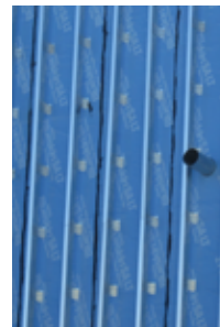
Clips en acier galvanisé avec profilés verticaux
