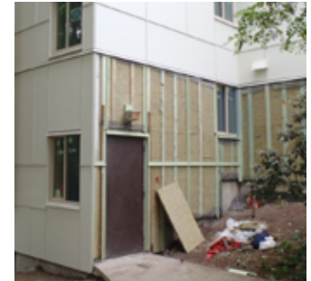
Longues vis à travers un lattis de bois posé à la verticale et l'isolant rigide COMFORTBOARD MC de ROCKWOOL dans un projet de bâtiment résidentiel multifamilial.
