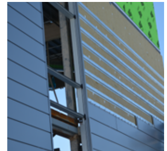
Longues vis à travers des profilés en oméga posés à l'horizontale et l'isolant rigide COMFORTBOARD MC de ROCKWOOL dans un projet de bâtiment commercial.
