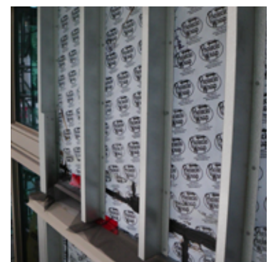
Profilés en Z verticaux posés sur une ossature d'acier. Les profilés sont fixés aux montants à l'arrière à entraxes de 16 po, ce qui entraîne d'importants ponts thermiques dans l'isolation extérieure.
