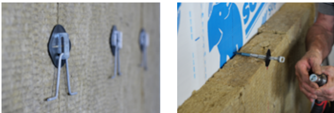
Exemples d'attaches à maçonnerie posées à travers l'isolant CAVITYROCK MD de ROCKWOOL MC .
