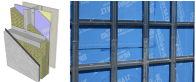
Profils en Z croisés constitués de profilés en Z horizontaux et verticaux fixés aux points de croisement.
