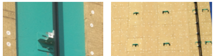
Exemple d'ancrage robuste comportant de grandes plaques d'acier soudées et un système de rails verticaux.
