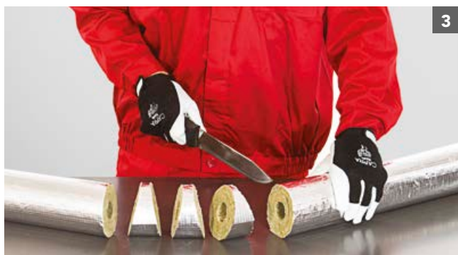
Ukázka řezání jednotlivých segmentů kolen
