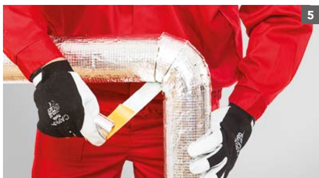
Přeplenění spojů kolena hliníkovou páskou
