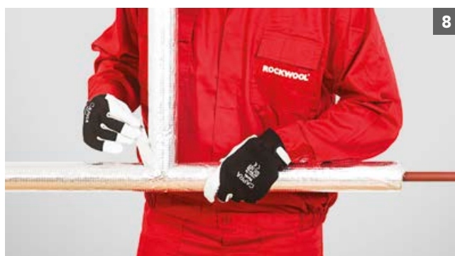
Přeplenění spojů hliníkovou páskou
