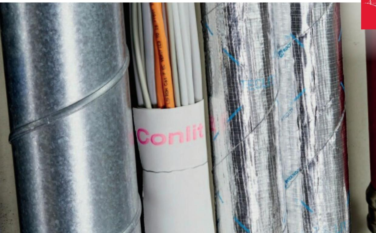
Die Conlit Bandage ist eine ca. 1 mm dicke flexible Matte, die aus einem Trägergewebe besteht, das beidseitig mit einem unter Hitzeeinwirkung aufschäumenden Material beschichtet ist. Sie wird im Conlit Abschottungssystem für Elektroleitungen und Elektroleerrohre verwendet.
