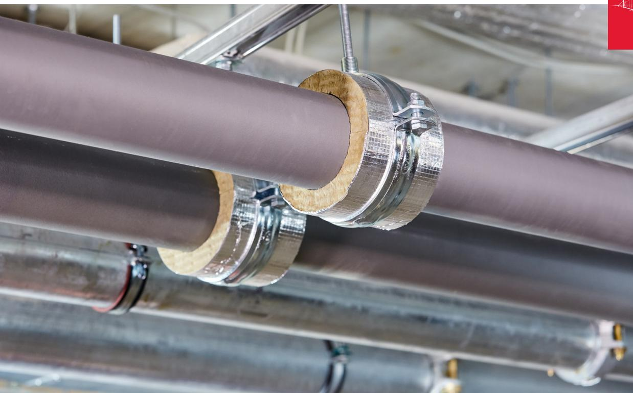
Der ROCKWOOL Rohrabhänger Teclit Hanger ist ein Bausatz bestehend aus einem sehr tragfähigen, hochdichten Steinwolle-Dämmkern und einer außenliegenden Rohrtragschelle. Der Dämmkern sorgt für eine kältebrückenfreie Abhängung bei optimaler Lastverteilung. Zum diffusionsdichten Anschluss an die Rohrdämmung ist er mit einer sehr robusten glasfaserverstärkten Aluminiumfolie kaschiert und mit einem selbstklebenden Überlappungsstreifen ausgestattet.
