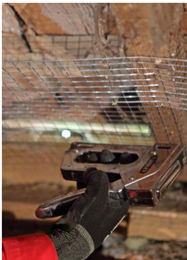
Découpe et pliage du grillage en correspondance des entrants (gauche) et maintien de l'aération (droite)
