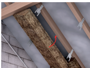
Mise en œuvre du panneau.
