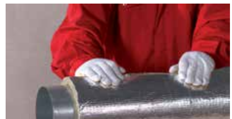
2. lépés – A szigetelés ráhajtása a csatornára
