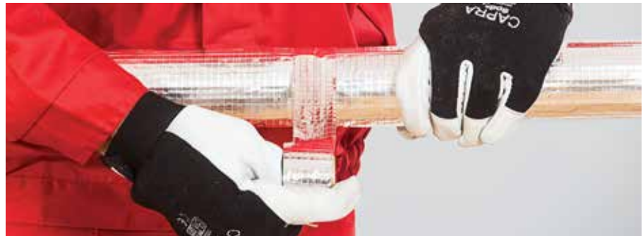
4. kép – Illesztések lezárása alumínium szalaggal
