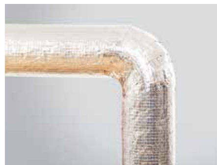
14. kép – Elkészült szigetelés PIPO ALS csőhéjjal
