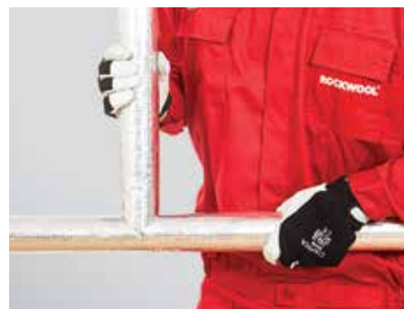
18. kép – Csatlakozó elemek hézagmentes illesztése
