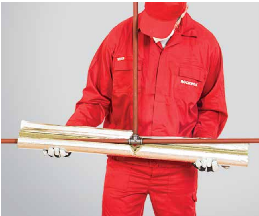
17. kép – Elemek felhelyezése a T elágazás száraira
