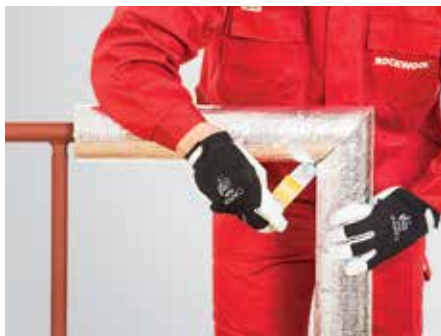
8. kép – Csatlakozások lezárása öntapadó alumínium szalaggal
