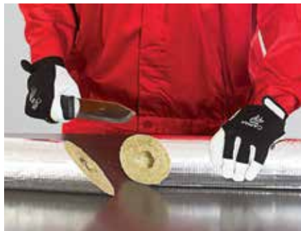
5. kép – A csőhéjat két 45°-os elemre vágjuk
