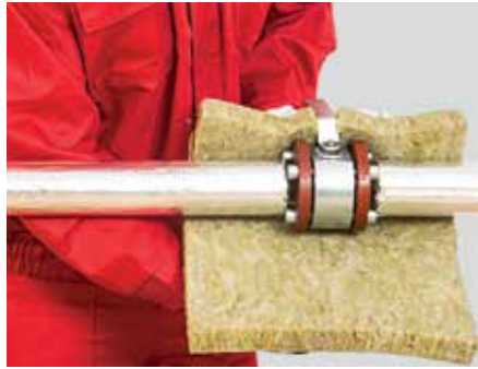
21. kép – A szelep körbeburkolása KLIMAMAT lamellal
