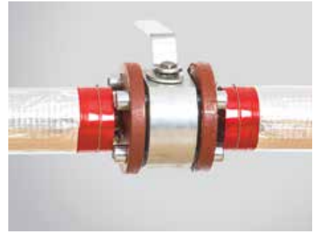
24. kép – Az elkészült szigetelés, ha nincs lehetőség a szelep szigetelésére
