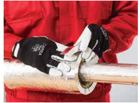
22. kép – A szigetelés lezárása alumínium szalaggal
