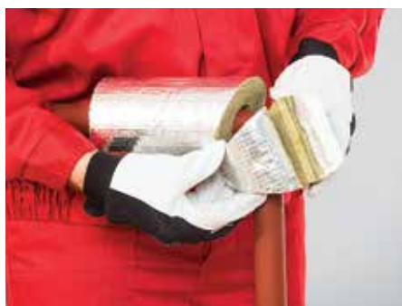
11. kép – Egy szegmens felhelyezése
