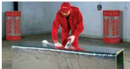
4. lépés – A hossz- és keresztirányú illesztések leragasztása öntapadó alumínium szalaggal
