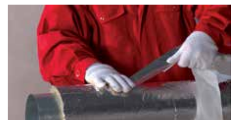
3. lépés – A hossz- és keresztirányú illesztések leragasztása öntapadó alumínium szalaggal
