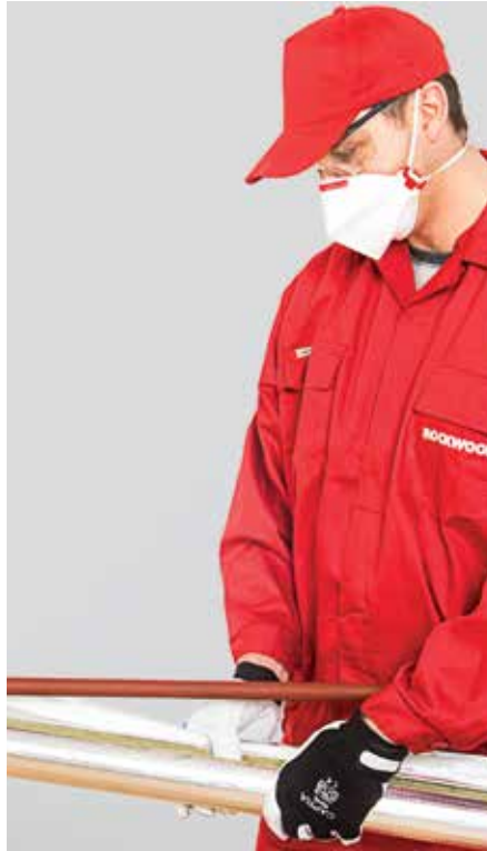
1. kép – A szigetelés felhelyezése
