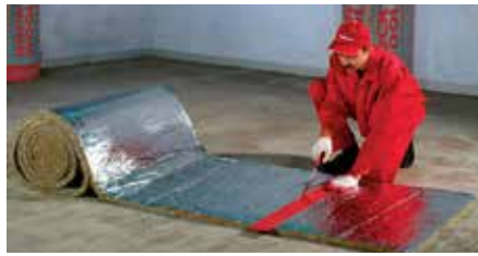
1. lépés – A szigetelés pontos méretre vágása
