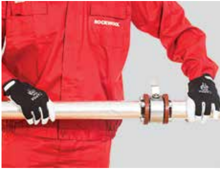
20. kép – A szerelvény egyenes szakaszainak szigetelése az elzáró szelepig
