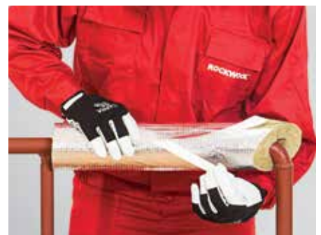
6. kép – A hosszirányú illesztések összeragasztása
