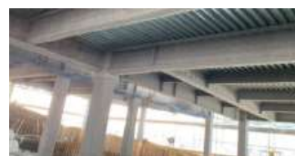
耐風仕様施工例
