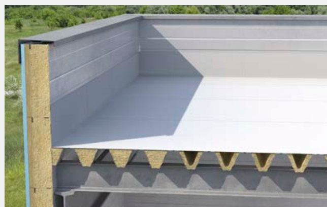
Układanie folii paroizolacyjnej PE.
